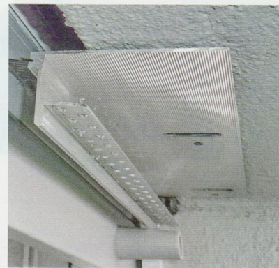
2 Mit Rollkas-Dämm- und Dichtleisten wird die Zugluft gestoppt.
