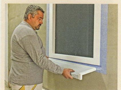
Schnell montiert: die neue Fensterbank Sto Fentra Profi – ideal für den Einbau in Wärmedämm-Verbundsysteme. (Foto: Sto)
