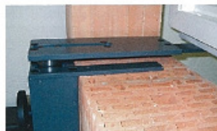
Ausrichten des Fensters per Handkurbel: Die Komfortausführung der Montagehilfe von Knelsen
