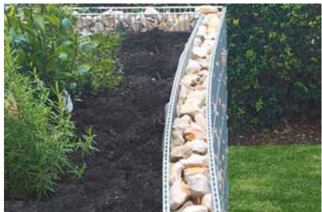
Verformung durch instabile Querstrebe
