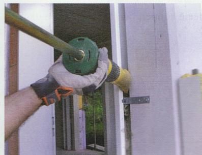
Zargen verfüllen mit den neuen Handmörtelpumpen. (Foto: B & M Vertriebs-GmbH)
